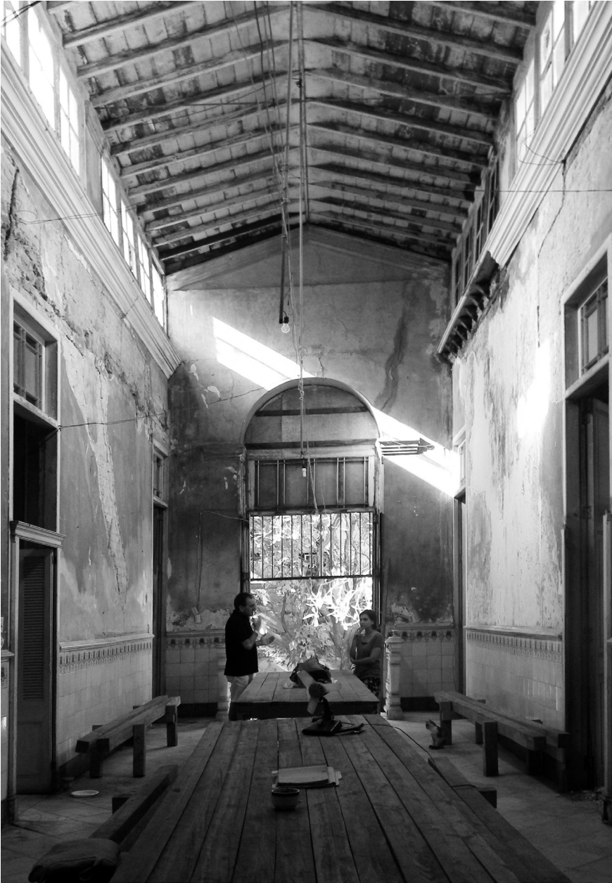
Fig. 3. Casona de Línea 508 antes de la intervención de Infraestudio. © Natalie Quer.
