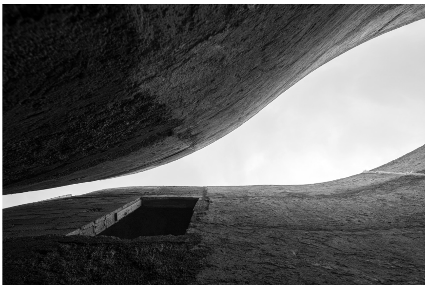
Fig. 13. Casa Gruta en construcción (2020). © Laurian Ghinitoiu.
